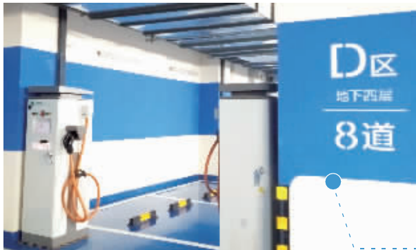
中建国际中心地下四层8道处
