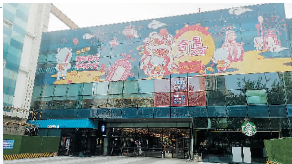
BHGMall北京华联常营购物中心的外立面全部遮挡,内部不同业态的分区正在进行整合。
