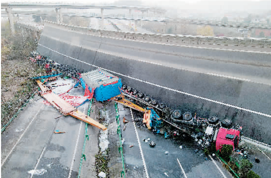
12月19日，航拍G50沪渝高速湖北鄂州段，高速公路引桥桥面侧翻事故现场。CFP图
