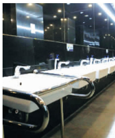
对100多个无障碍卫生间进行改造升级
