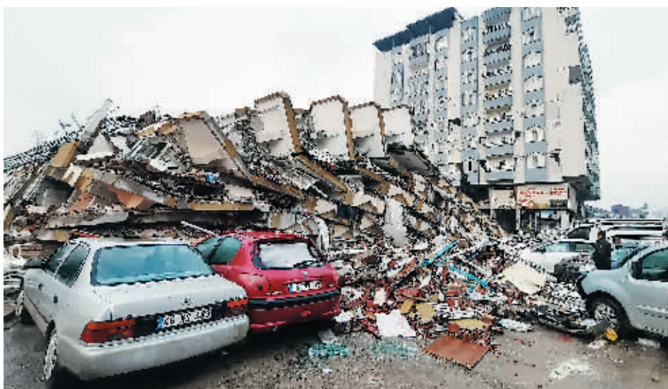
7日,土耳其卡拉曼马拉什一处倒塌的建筑。新华社图
