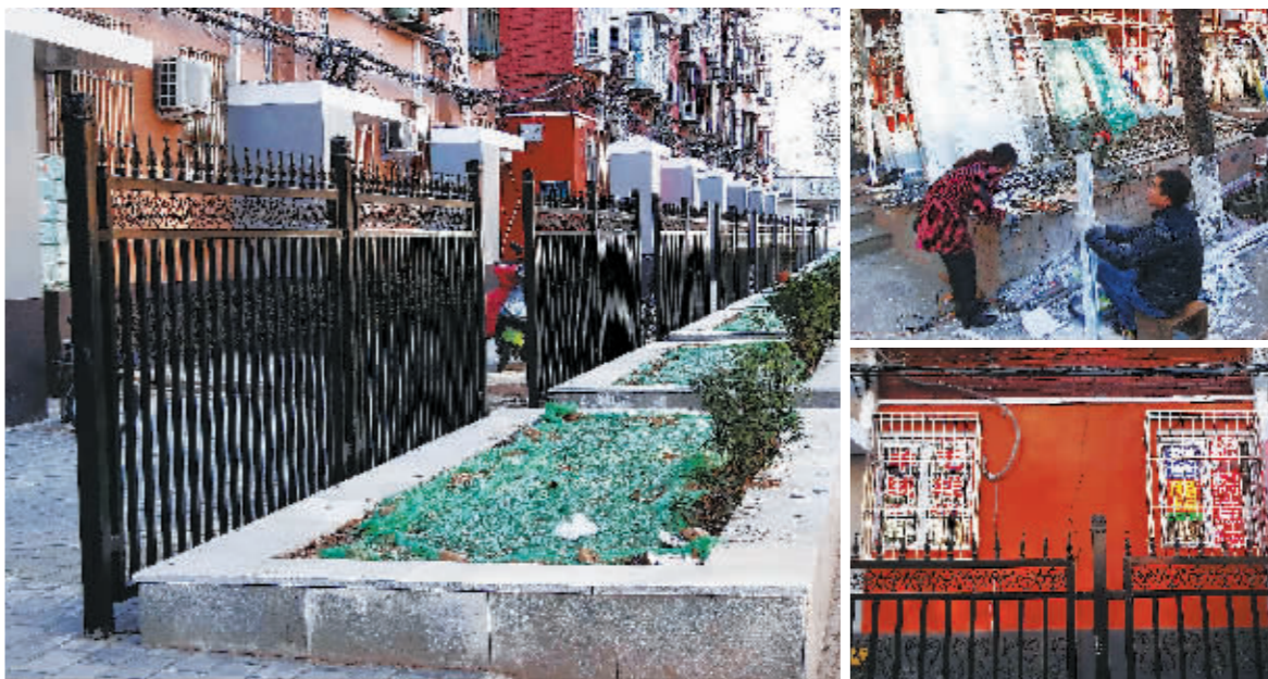
青年沟路东城区辖区内,已经完成拆建工作的楼体前,建起了艺术栏杆和花坛,东段北侧朝阳区辖区楼体已搭好支架,12月15日将正式开工;拆建后,部分底楼仍持续着原有的业务,并未回到应有的住宅功能。
