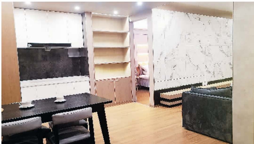
地面、墙面、顶面、厨房等空间的硬装产品都在中寓住宅的工厂生产,现场安装即可
