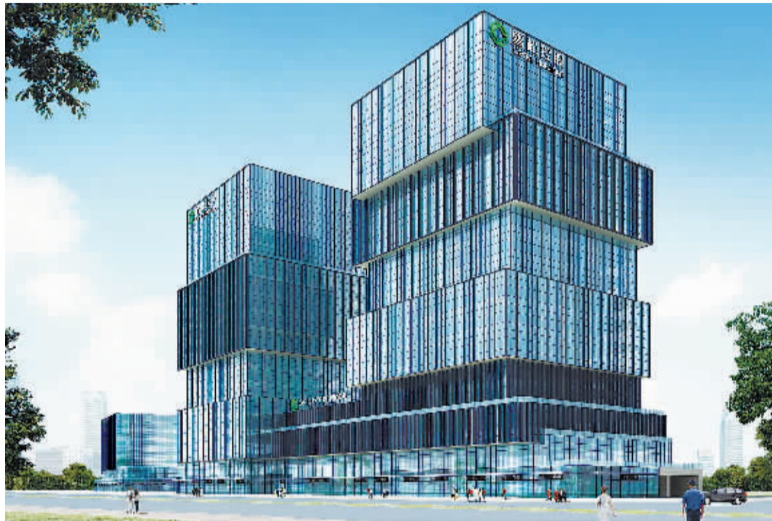
位于广州市黄埔区在建的雪松总部大楼
