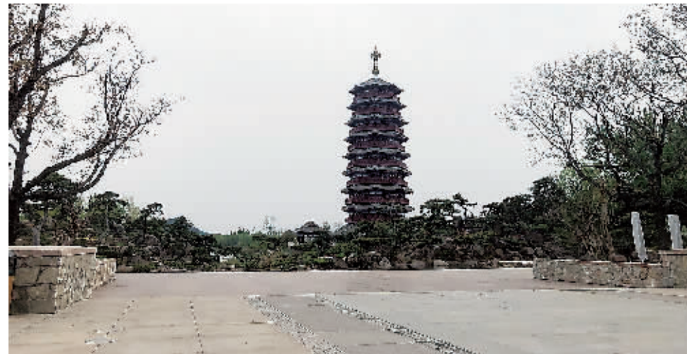
图为高处封闭期的怀柔雁栖塔
