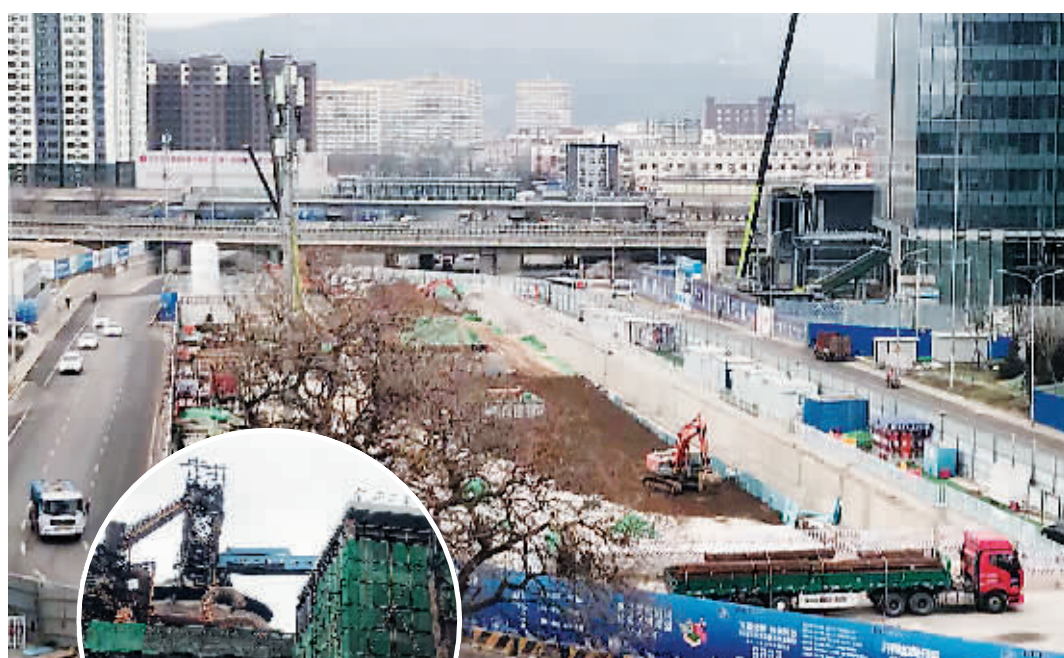
正在建设的金安桥站交通一体化及工业遗产修缮项目
