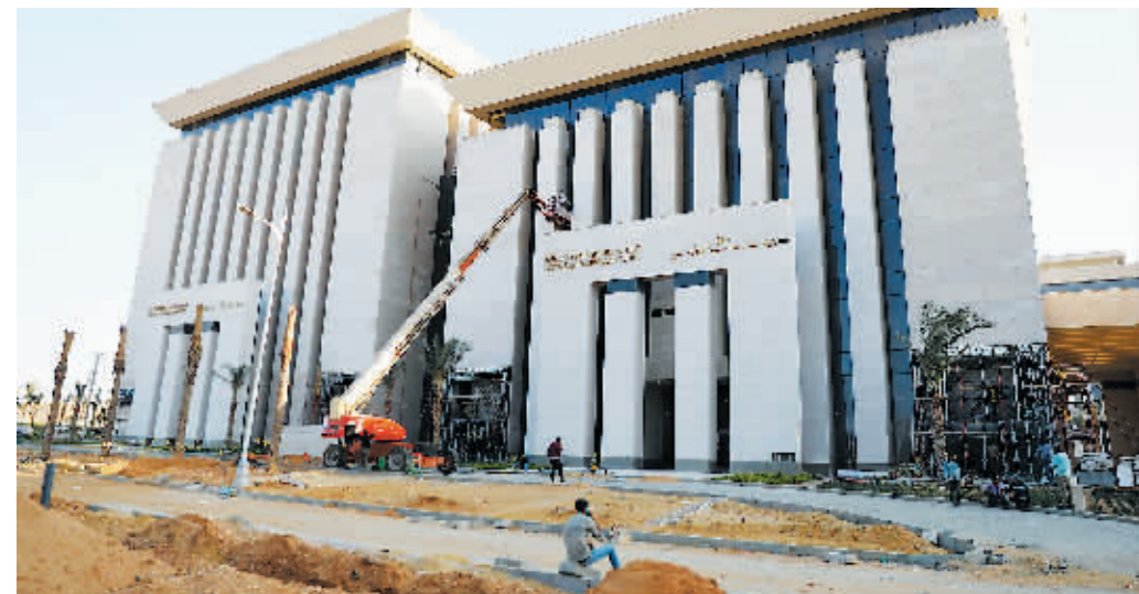
3日，工人在埃及新行政首都的农业与土地改造部新大楼外施工。新华社图
