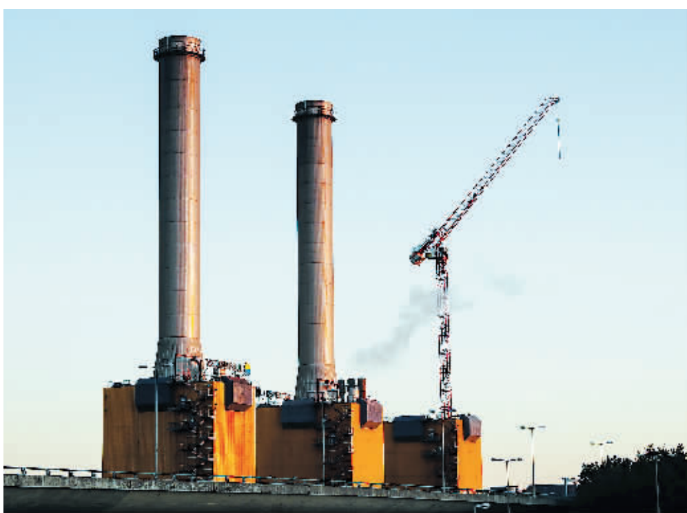
此前,德国首都柏林一座正在拆除烟囱的热电厂。新华社图
