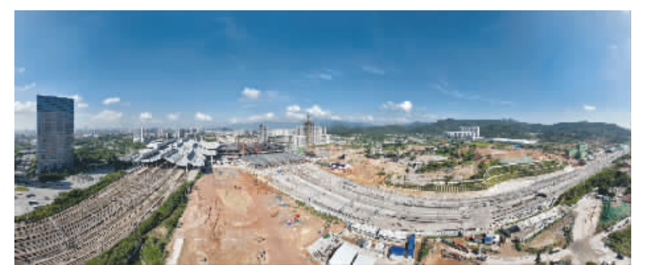
新建福州-厦门铁路全线铺轨贯通 新华社摄
