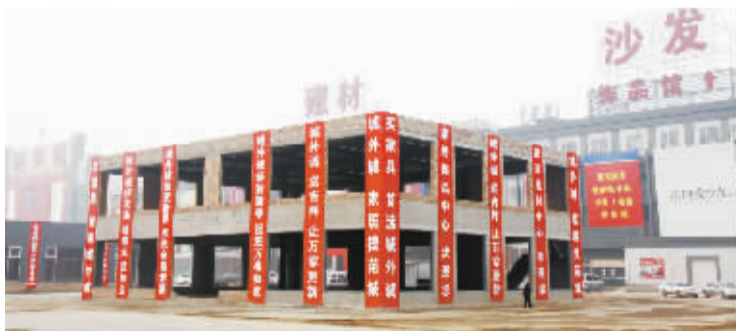
正在城外诚广场建设的这幢二层小楼，将成为独立的广场主题馆。
